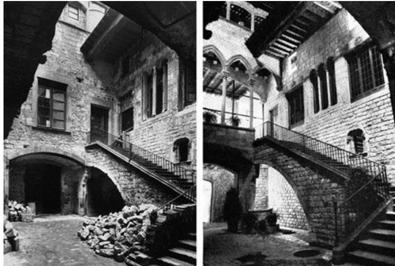
Ilustración 06. Palacio Berenguer de Aguilar (actual Museo Picasso) en 1955 y en 1964. Introducción de una galería neogótica a imitación de otra conservada en una de las caras del patio
