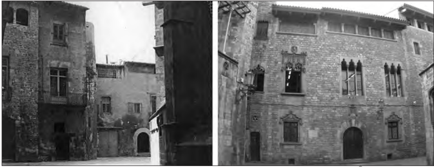
Fig. 2 – Barcellona. Casa de los Canónigos nel 1927 e rifacimento nel 1930 secondo la tipologia della “casa catalana”, con elementi provenienti dalle demolizioni della via Layetana e di altri fabbricati.
